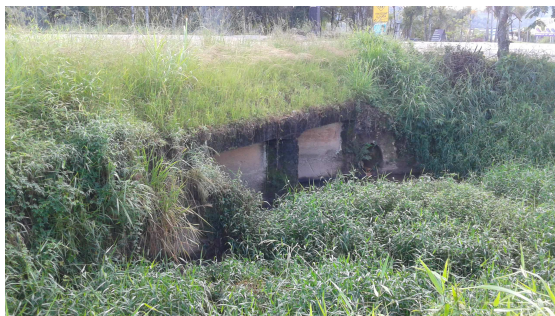
Foto 02 – Articulação 01 – execução de plantio de grama e desassoreamento e limpeza de leito
