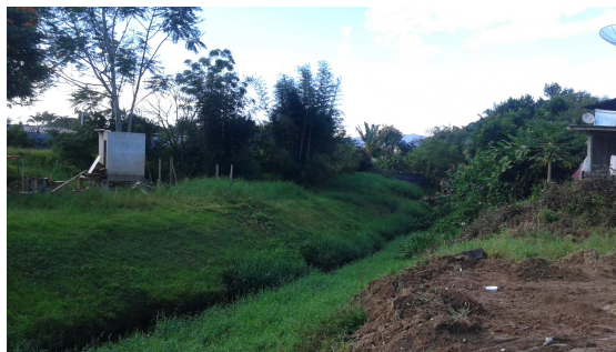
Foto 07 – Articulação 04 – execução parcial de plantio de grama e desassoreamento e limpeza de leito
