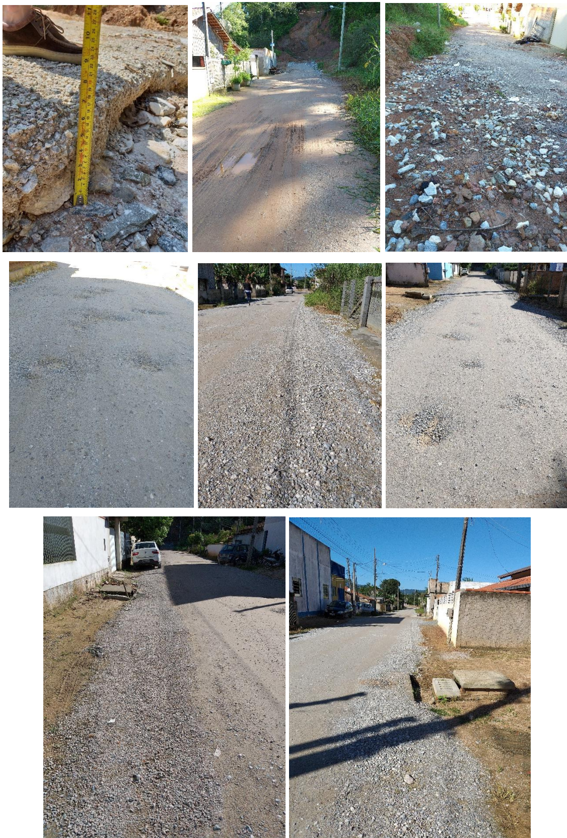
Foto 02: sub-base de rachão e base de brita graduada em 09/04/2019.
