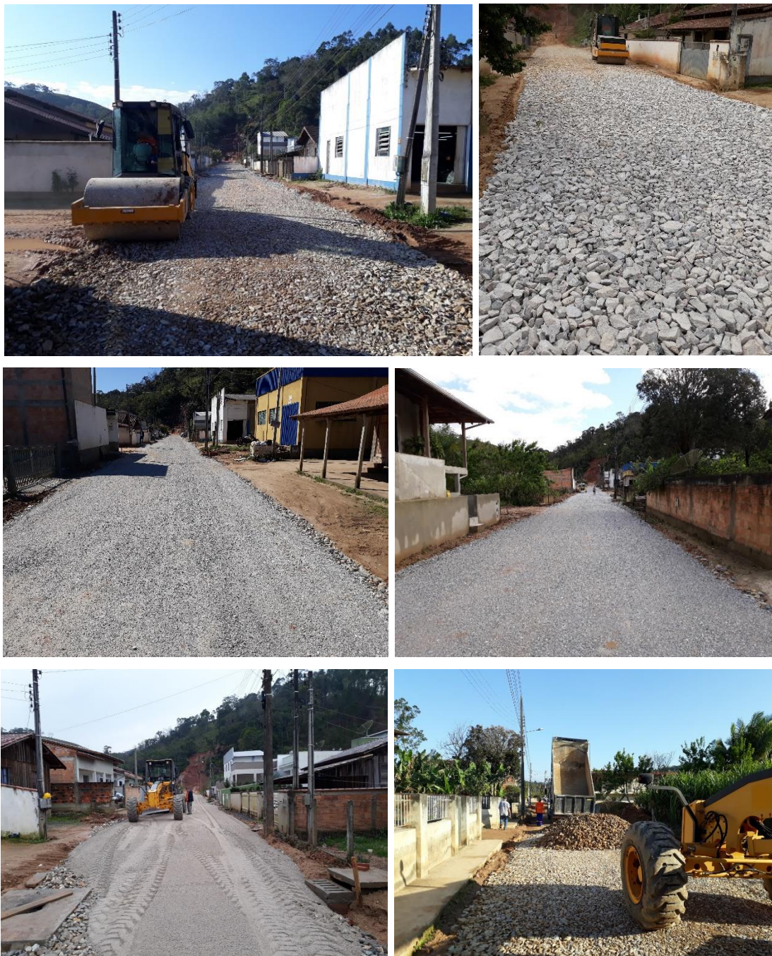
Foto 01: sub-base de rachão e base de brita graduada na época da execução.
