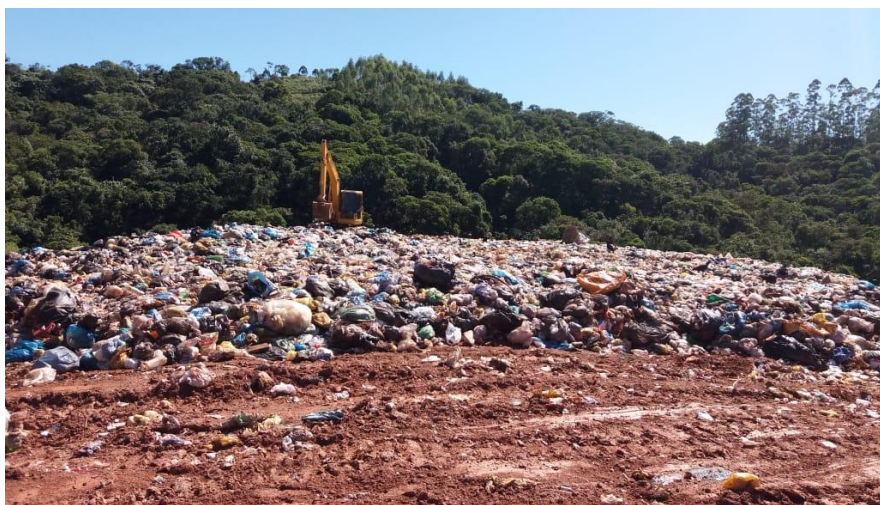
Vista frontal de avanço da frente de serviço
