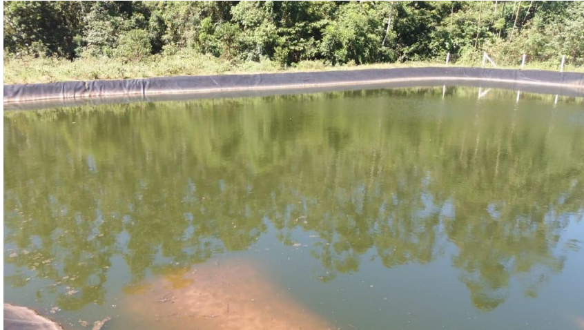
Lagoa 01 – entrada “Anaeróbia”.
