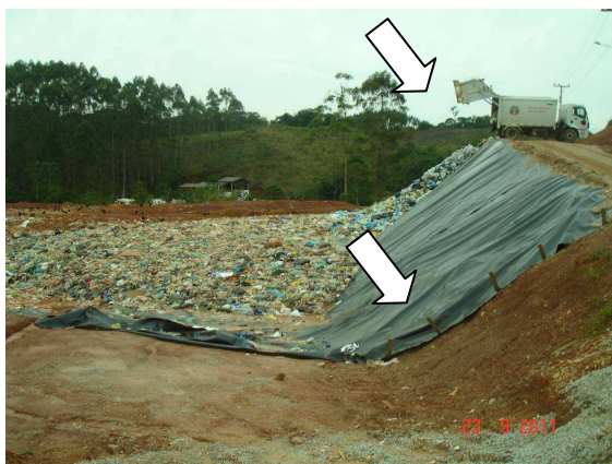
Foto 03 – Frente Aberta; - Método de fixação do PEAD; - Segurança do caminhão compactdor.
