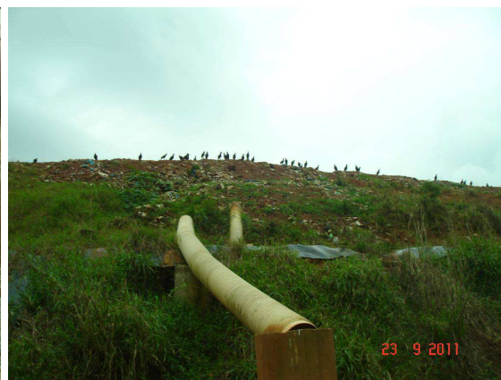
Foto 04 – Sistema de drenagem de percolados
